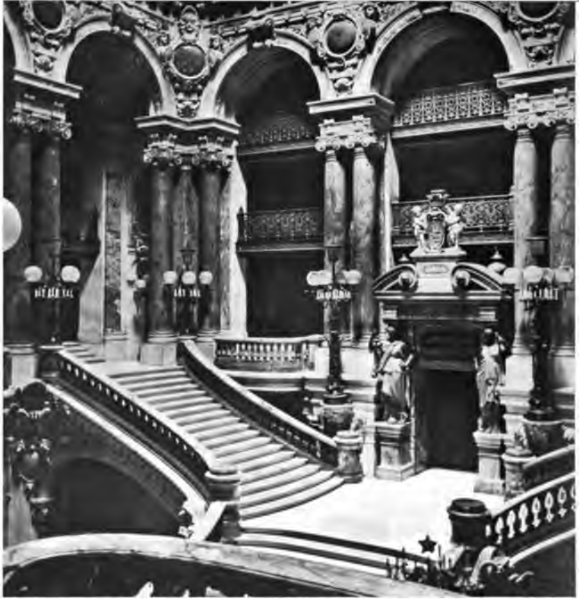
Fig. 102. — Escalier à double volée de l'Opéra de Paris. (Œuvre de Charles Garnier).
